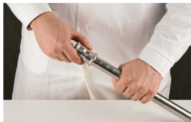
Рис. 14 — введение трубы в пресс-фитинг
